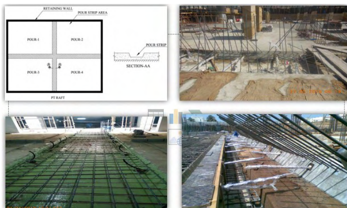
5. POUR STRIP ARRANGEMENT & CONCRETING
